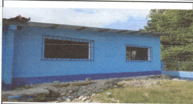
Foto 1: se observa que el techo de lámina ya fue sustituido, las ventanas y balcones ya fueron instalados.
