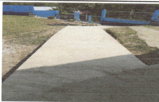
Foto 4: se observa que el encaminamiento ya fue construido.
