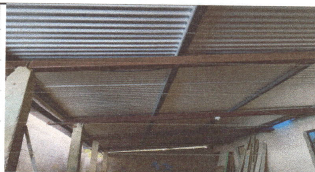
Foto 6: se observa que la cubierta de lámina ya fue sustituido e instalado el canal.
