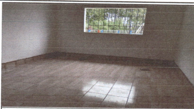
Foto 2: se observa que el piso cerámico fue ya instalado
